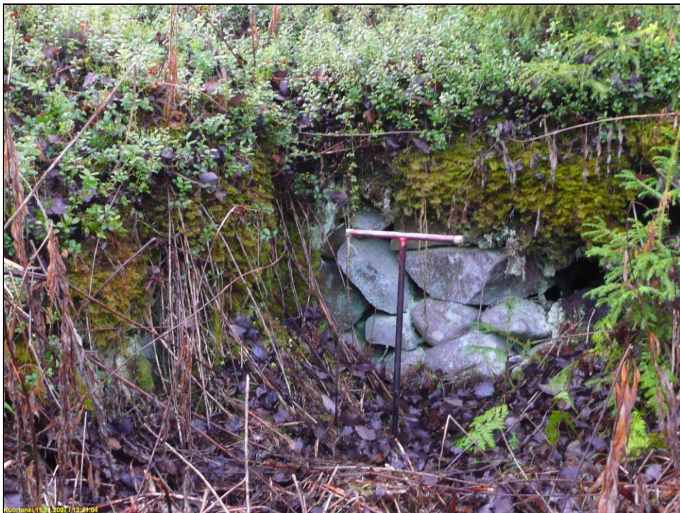
Kuopan kivettyä seinämää.
